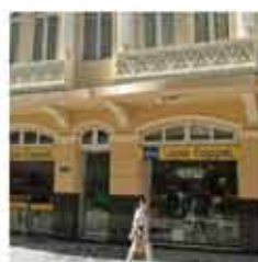
CURITIBA - CENTRO RUA XV DE NOVEMBRO, 562, PROX. AO TÚNEL ESTÁÇÃO CENTRAL
