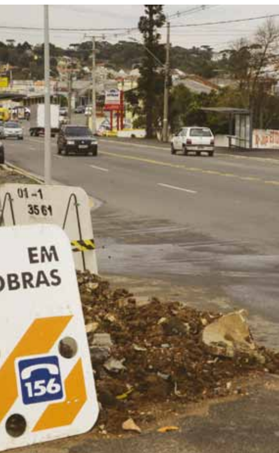
_ AS OBRAS NA SALGADO FILHO INCLUI DEMOLIÇÃO DE PAVIMENTO, TERRAPLENAGEM, REGULARIZAÇÃO E COMPACTAÇÃO DO SUBLEITO, DRENAGEM, PAISAGISMO, SINALIZAÇÃO HORIZONTAL E VERTICAL E INFRAESTRUTURA DE FIBRA ÓTICA
